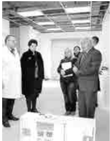
Первый этап - ремонт помещений.
