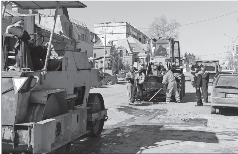
Идёт ямочный ремонт на ул. Революционная. Фото Андрея ШАЛЯПИНА.
